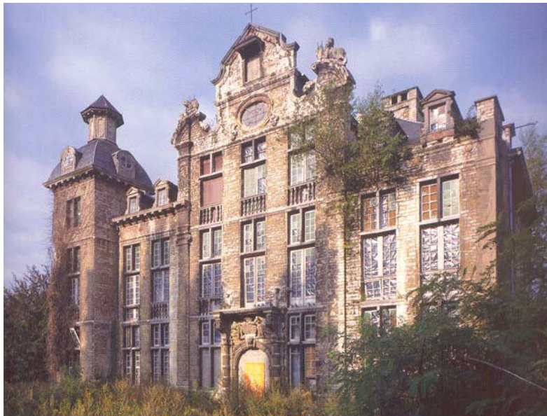
Het kasteel in zijn huidige toestand. Voorgevel.
